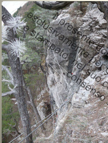
Interventi di miglioramento del fattore di sicurezza con funi e tiranti a barra
